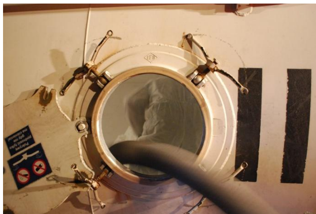
Obr. 4. Dočištění uvnitř cisterny
