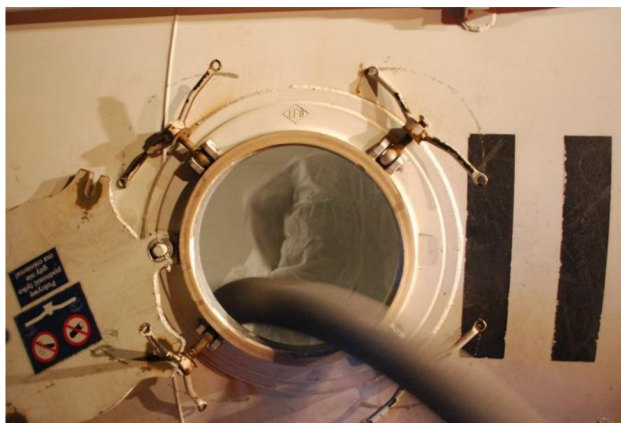
Obr. 4. Dočištění uvnitř cisterny
