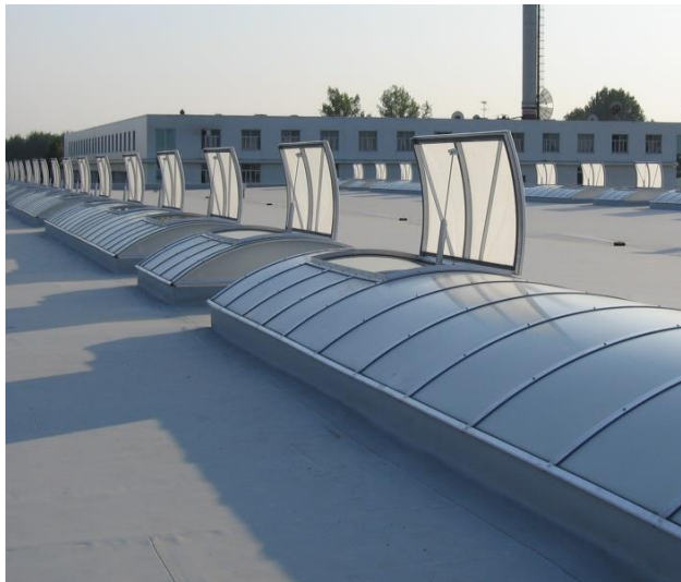
Obrázek 9 - Výměníky fungující jako přirozený odvod tepla a kouře
