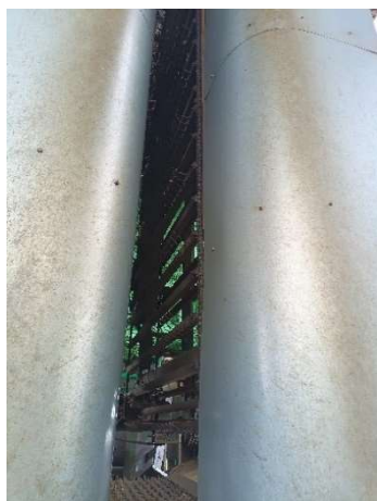
Příloha 7 česací stěna – vstup
