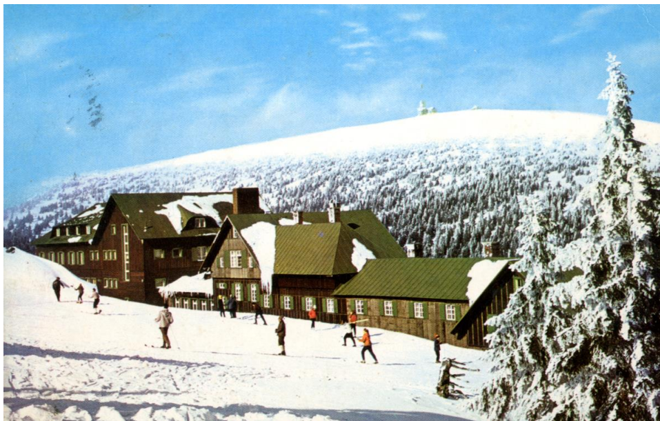
Obr. 11: Ovčárna s patrným rozšířením o nově dostavěné vyšší objekty v období 1946–1960 Zdroj: soukromý archiv
