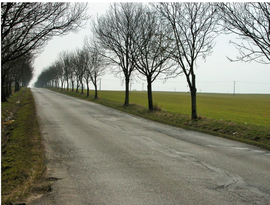
Obrázek 9-6 - Současný stav v místě DZ3, pohled od Světic (foto: autorka)
