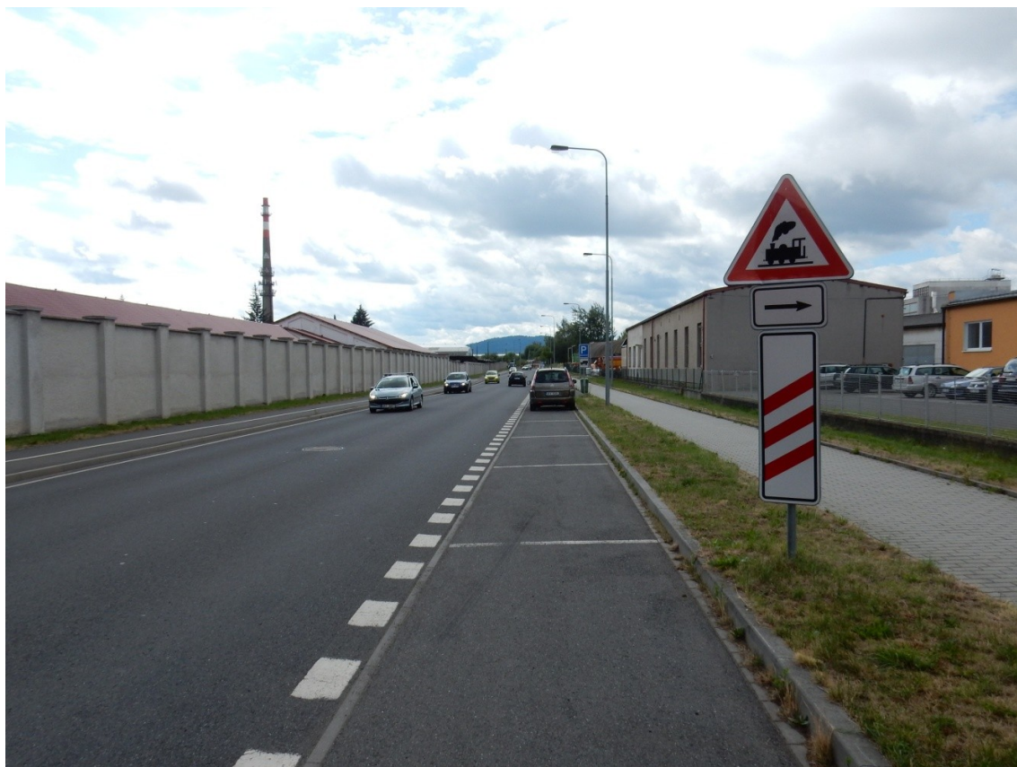
Fotografie „Návěstních desek“ před železničním přejezdem P8385
