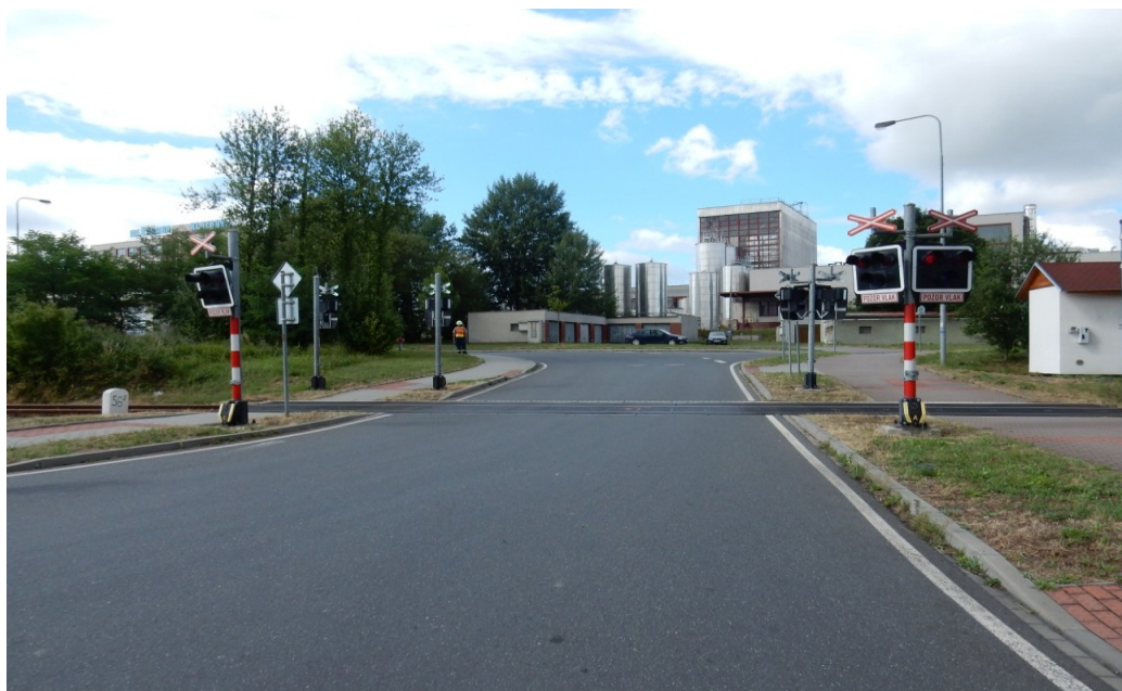
Obr. 4.3 Železniční přejezd P8385
