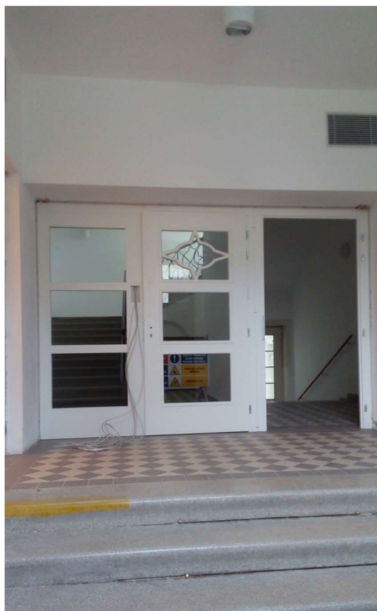
Obr. č. 8: Vstup do JZ křídla v závěru rekonstrukce roku 2016.
