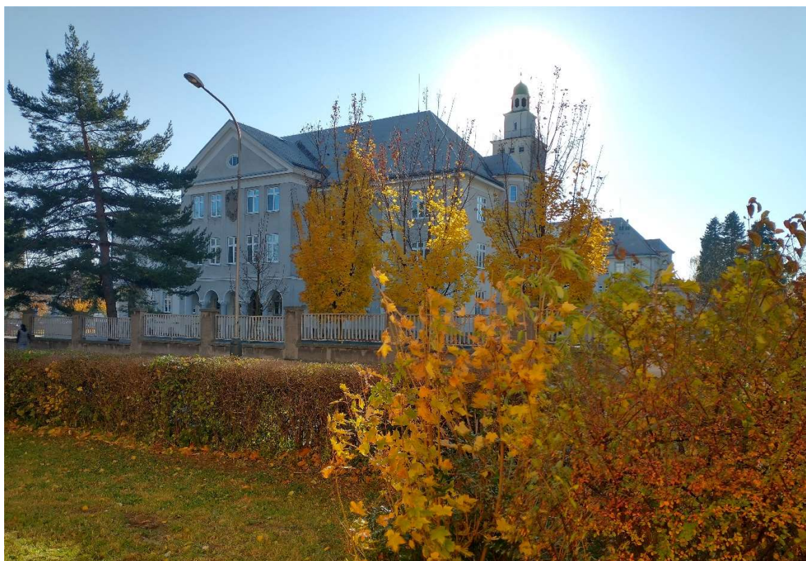
Obr. č. 26: Opava, Franciscaneum. Severní pohled 2021.
