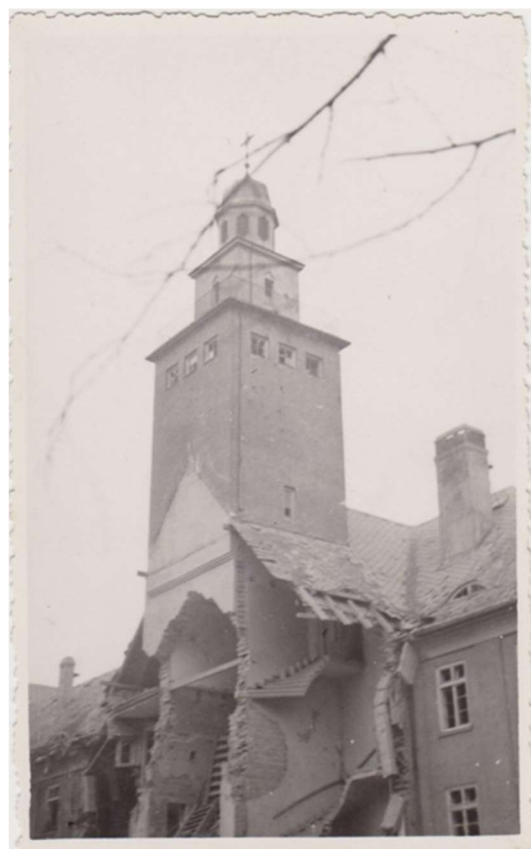
Obr. č. 20: Stojící věž po bombardování 18. prosince 1944.
