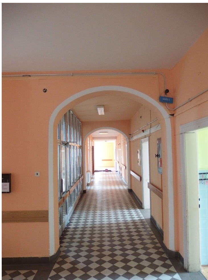
Obr. č. 39: Vnitřní chodba před rekonstrukcí 2016.
