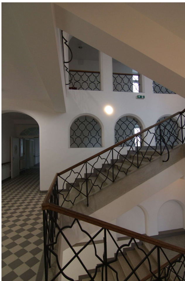
Obr. č. 38: Vnitřní schodiště po rekonstrukci 2016.
