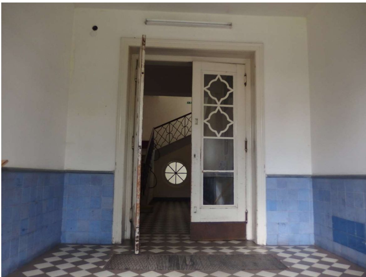
Obr. č. 35: Jihozápadní vstup do budovy rok 2015.
