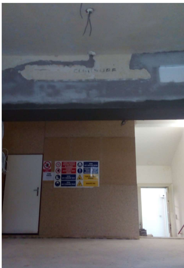
Obr. č. 7: Vstup do JZ křídla při rekonstrukci v roce 2016.
