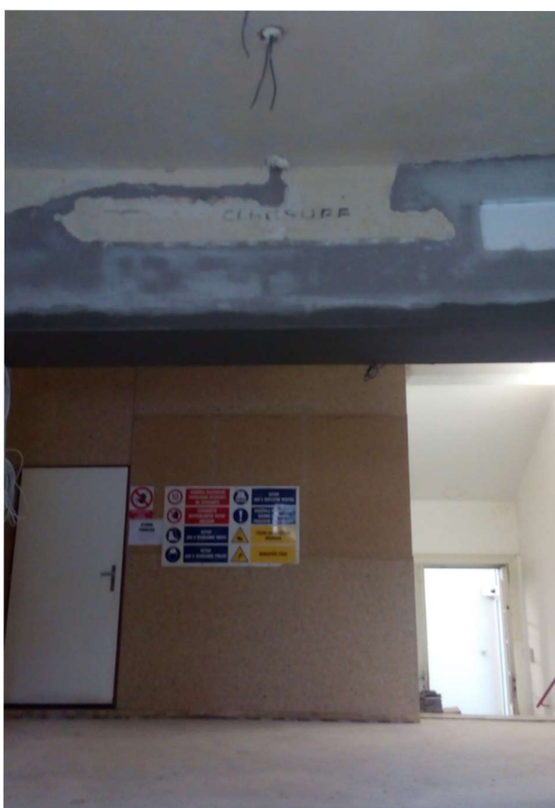
Obr. č. 7: Vstup do JZ křídla při rekonstrukci v roce 2016.
