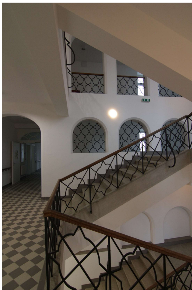
Obr. č. 38: Vnitřní schodiště po rekonstrukci 2016.
