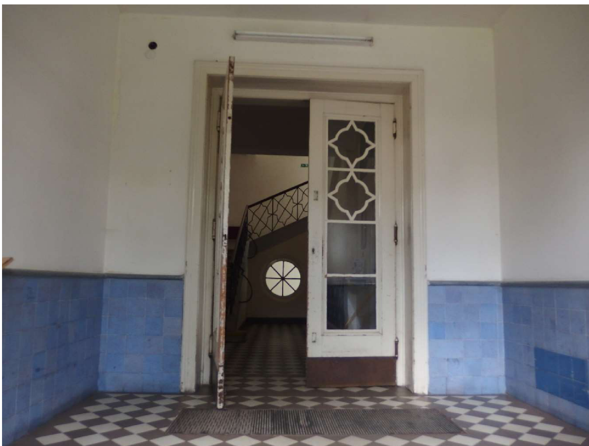
Obr. č. 35: Jihozápadní vstup do budovy rok 2015.
