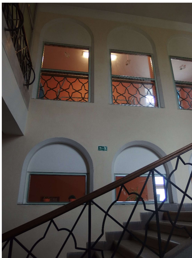
Obr. č. 37: Vnitřní schodiště před rekonstrukcí 2016.
