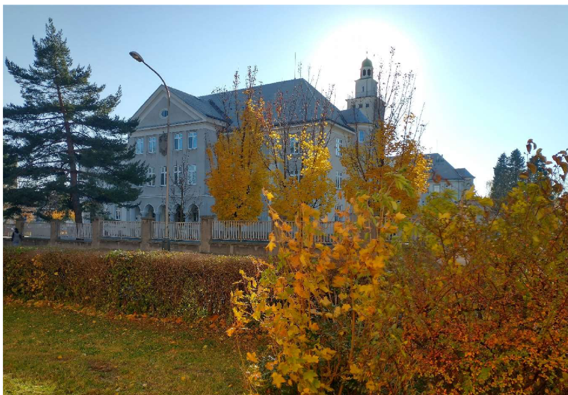
Obr. č. 26: Opava, Franciscaneum. Severní pohled 2021.
