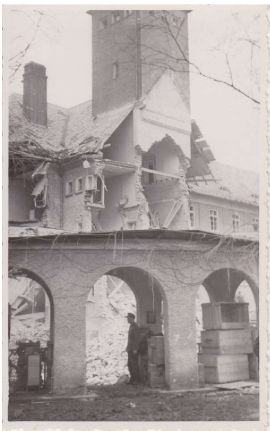
Obr. č. 19: Pozůstatek ambitů ke kněžskému bytu po bombardování 18. prosince 1944.
