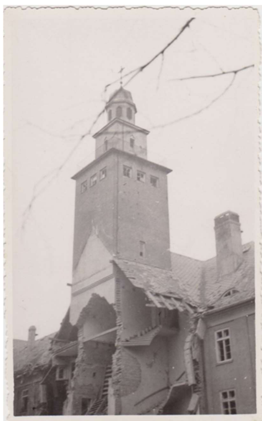
Obr. č. 20: Stojící věž po bombardování 18. prosince 1944.
