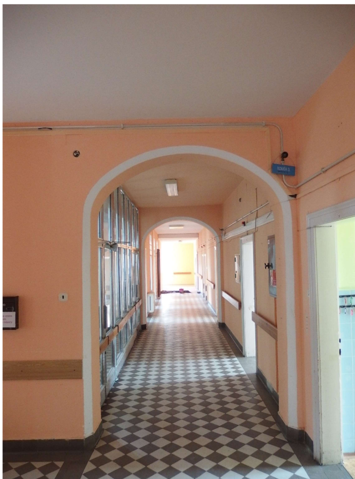
Obr. č. 39: Vnitřní chodba před rekonstrukcí 2016.
