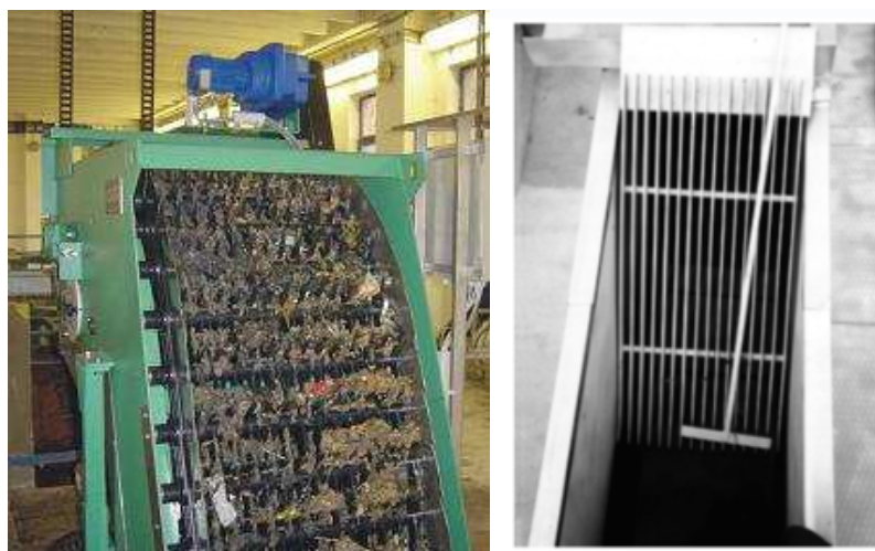
Obrázek 3.1 (vlevo) Samočišící hrubé česle [18]
