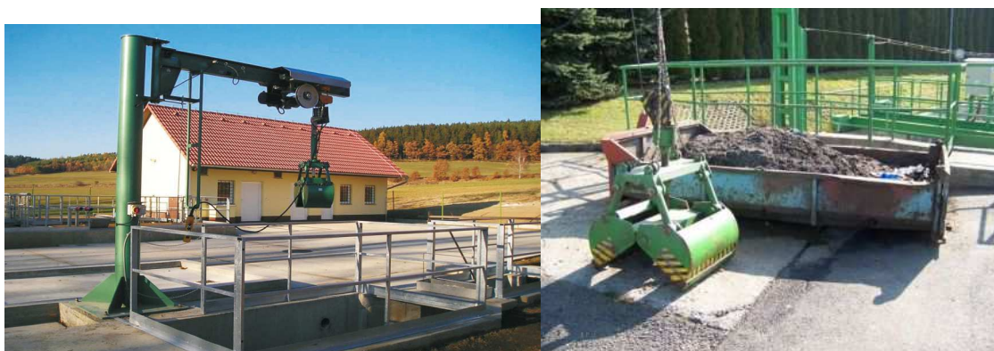
Obrázek 3.16, 3.17 Mechanicky vyklízený lapák štěrku [27]
