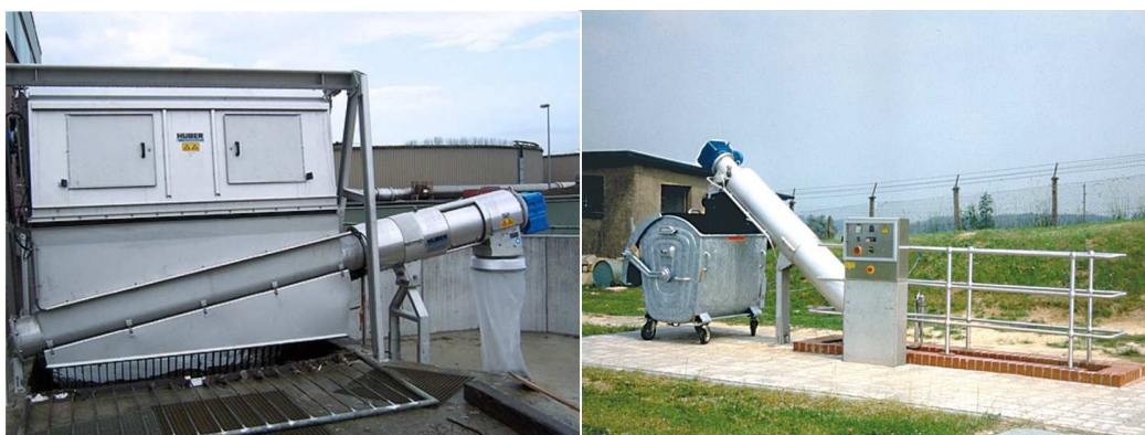
Obrázek 3.11, 3.12 Lis na shrabky napojený přímo na česlích [20]
