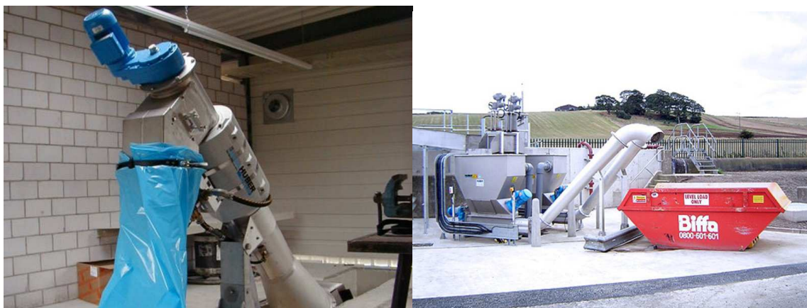
Obrázek 3.7, 3.8 Pytel na shrabky v porovnání s kovovým kontejnerem [20]
