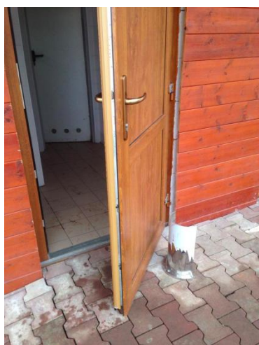
Obrázek 1. Přístup na WC
