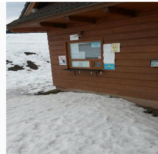
Obrázek 12. Přístup k pokladně
