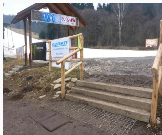
Obrázek 18. Schody u vstupu do areálu
