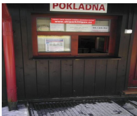
Obrázek 3. Přístup k pokladně
