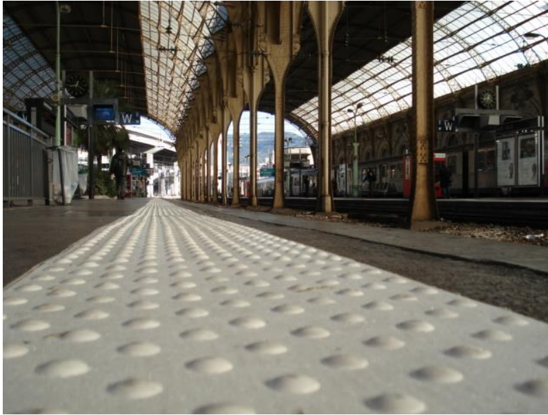
Obr. 26 Varovný pás z metakrylátové pryskyřice na nástupišti
