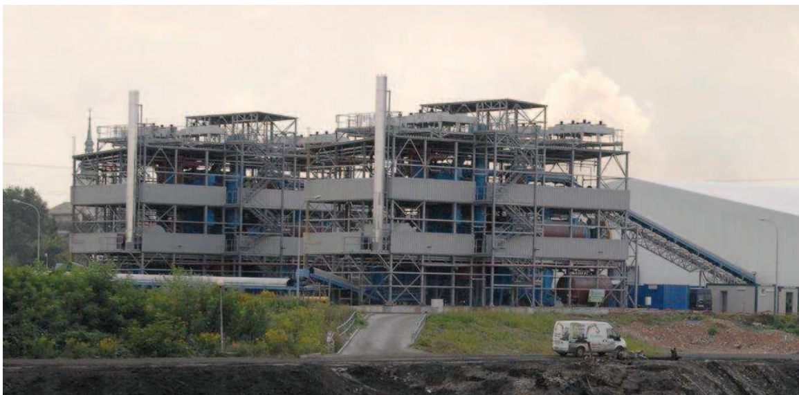
Obr. č. 9: Zařízení nepřímé termické desorpce v lokalitě Laguny Ostramo (ČISTÁ OSTRAVA 2013)
