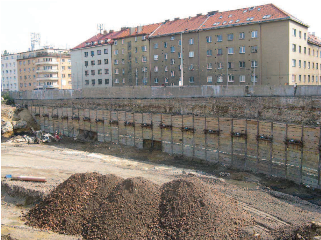
Příloha č. 5: Těžba nesaturované zóny v roce 2012 společně s budováním záporové stěny (Michal Turek 2012)
