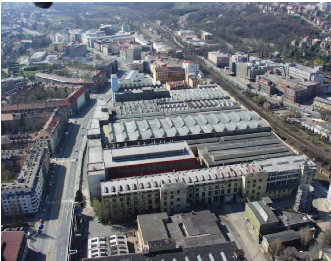
Příloha č. 1: Letecký snímek na areál ČKD Elektrotechnika před zahájením sanace (URBANIST 2013)
