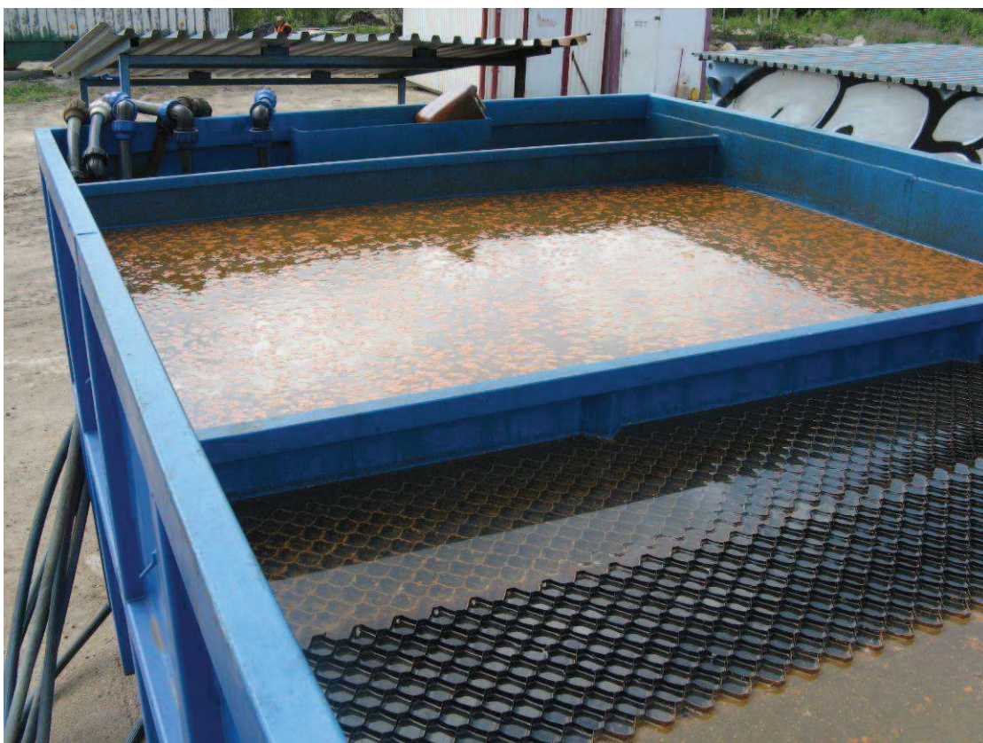
Příloha č. 3: Usazovací nádrž sanační stanice SAN1-R (Michal Turek 2012)
