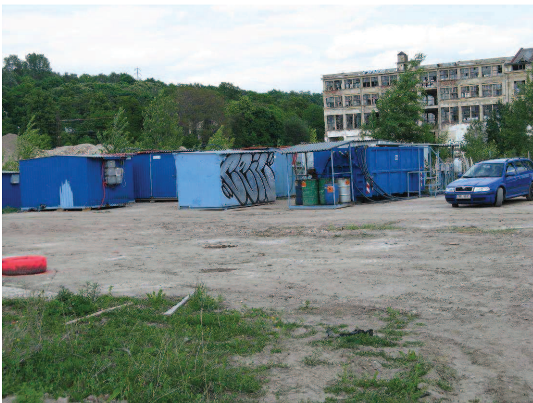
Příloha č. 2: Pohled na sanační stanice (Michal Turek 2012)
