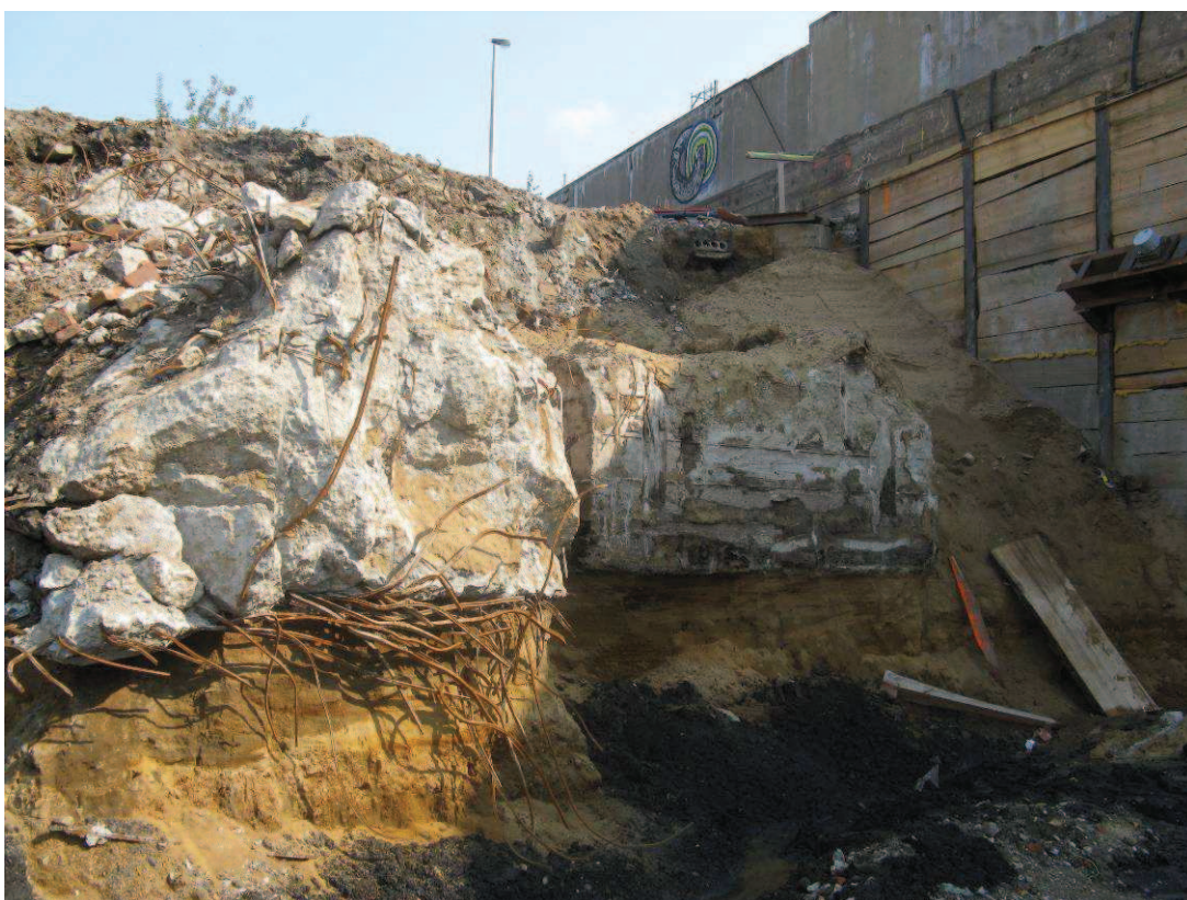
Příloha č. 8: Základy bývalých výrobních hal (Michal Turek 2012)
