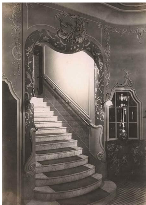
Obrázek 9: Původní schodiště do prvního patra
