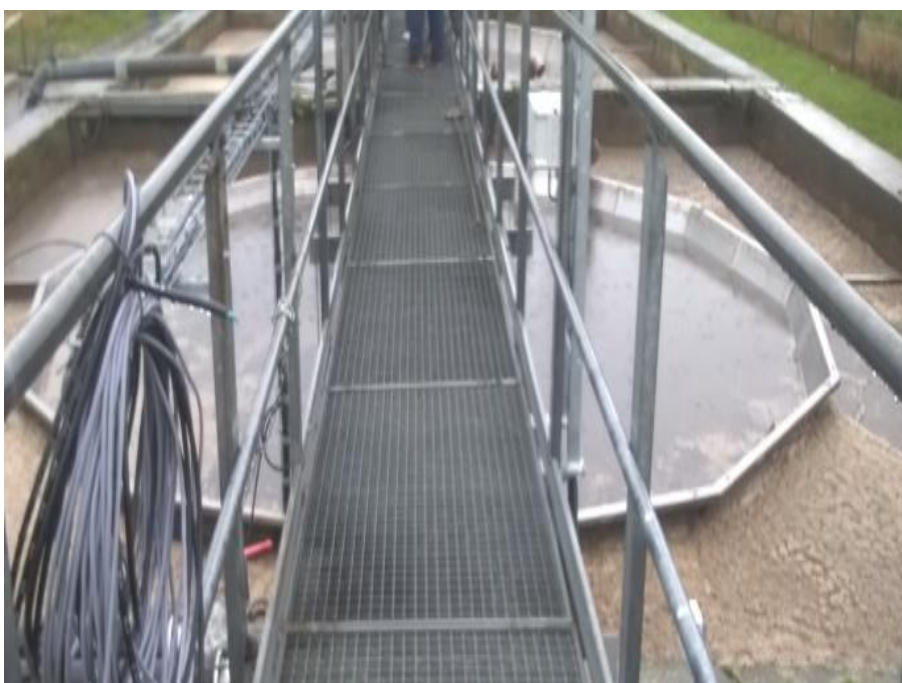
Příloha 12: Biologická část s vnořenou dosazovací nádrží (Telecká, 2020)
