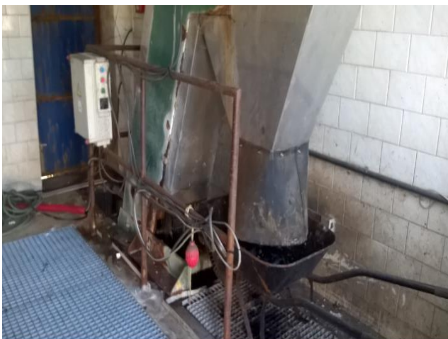
Příloha 2: Hrubé předčištění, česle – před intenzifikací (Telecká, 2016)
