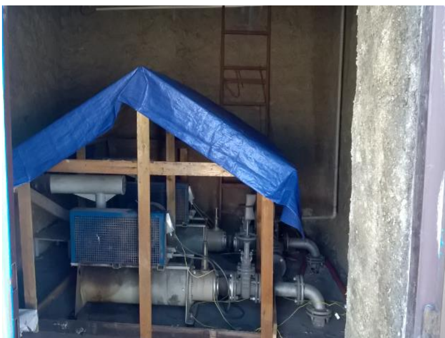
Příloha 4: Dmyhárna - před intenzifikací (Telecká, 2016)
