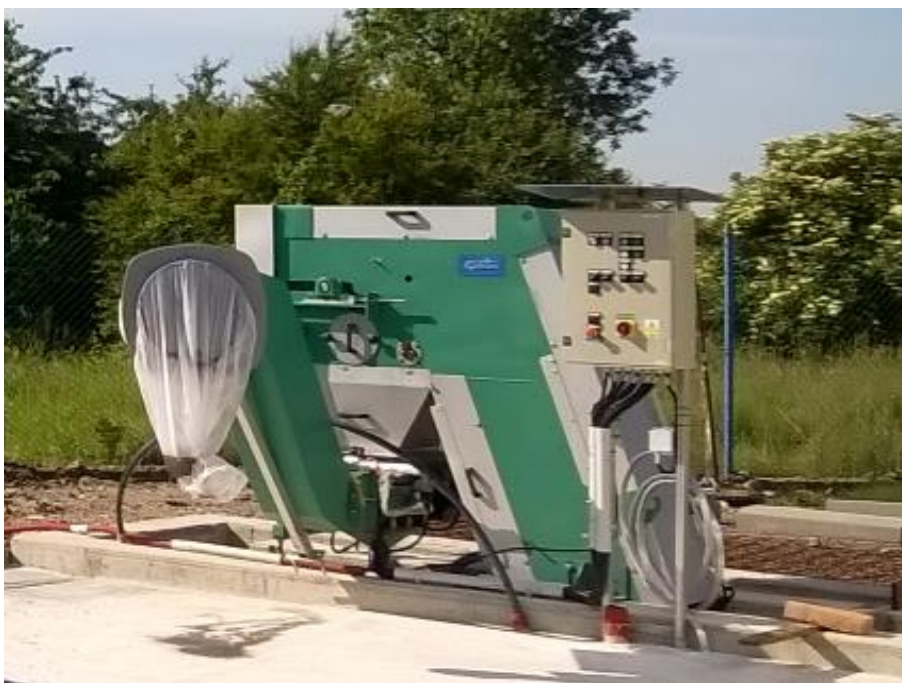
Příloha 6: Hrubé předčištění, strojí česle – po intenzifikaci (Telecká, 2020)
