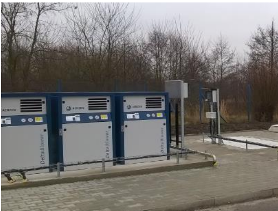
Příloha 8: Dmychadla - po intenzifikaci (Telecká 2020)
