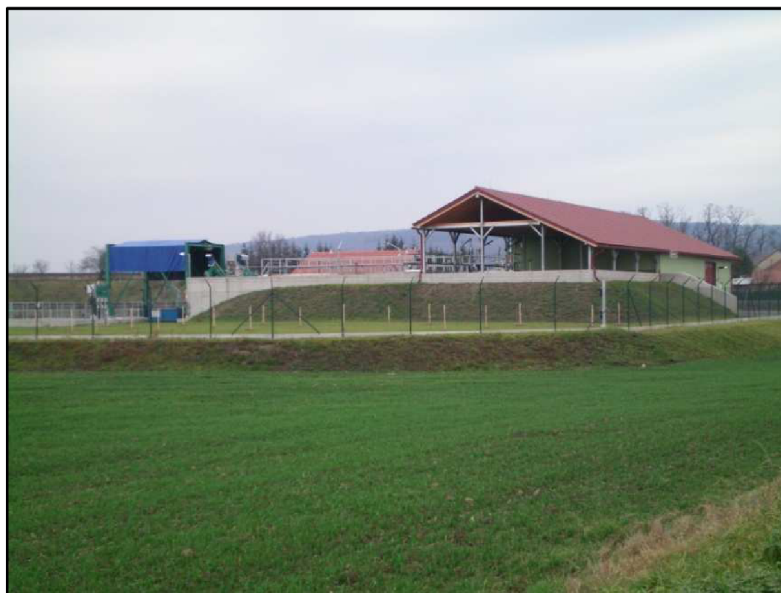
Obr. č. 5.1.8 – 1 – Čistírna odpadních vod Kostelec na Hané
