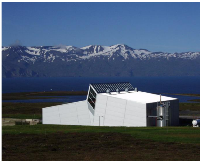
Obr. 2.10 Geotermálna elektráreň Orkuveita Húsavíkur [7]
