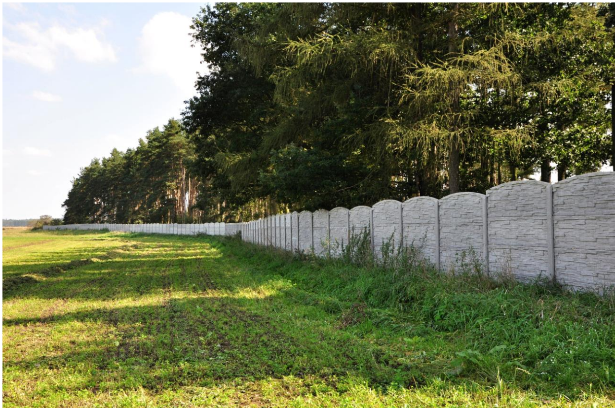
Obr. č. 1: Oborní plot z betonových prefabrikátů, Obora Svárava.
