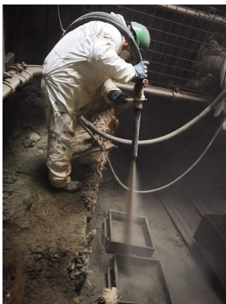
Obr. 13 Odborný pracovník provádějící nástřik směsí
