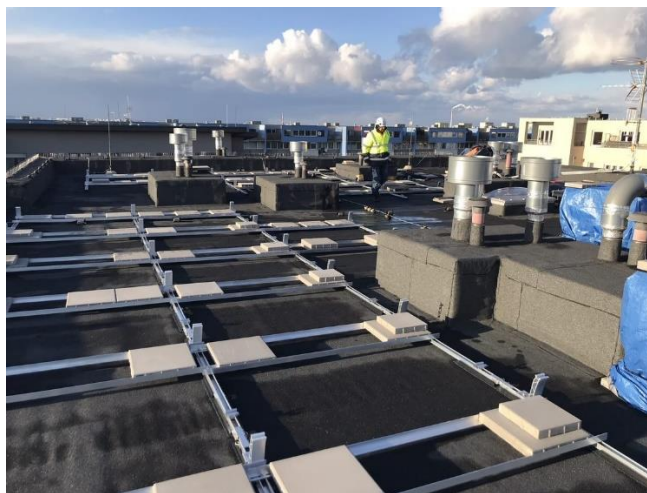
Obrázek 35. Způsob montáže fotovoltaických panelů na ploché střechy [26]
