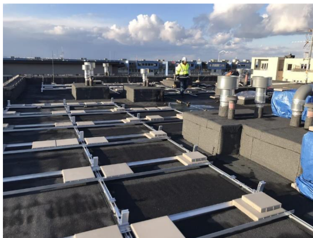
Obrázek 35. Způsob montáže fotovoltaických panelů na ploché střechy [26]
