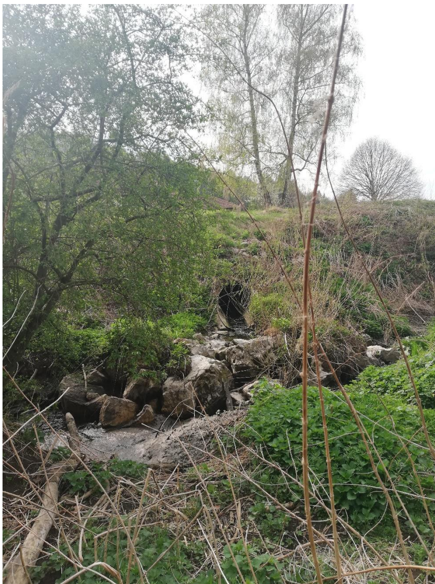
Příloha 11: Vypouštění vyčištěných vod z ČOV do závrtu PŽ/67 a Pon_Hřeb, fotograf: Marcela Čachotská, jaro 2022
