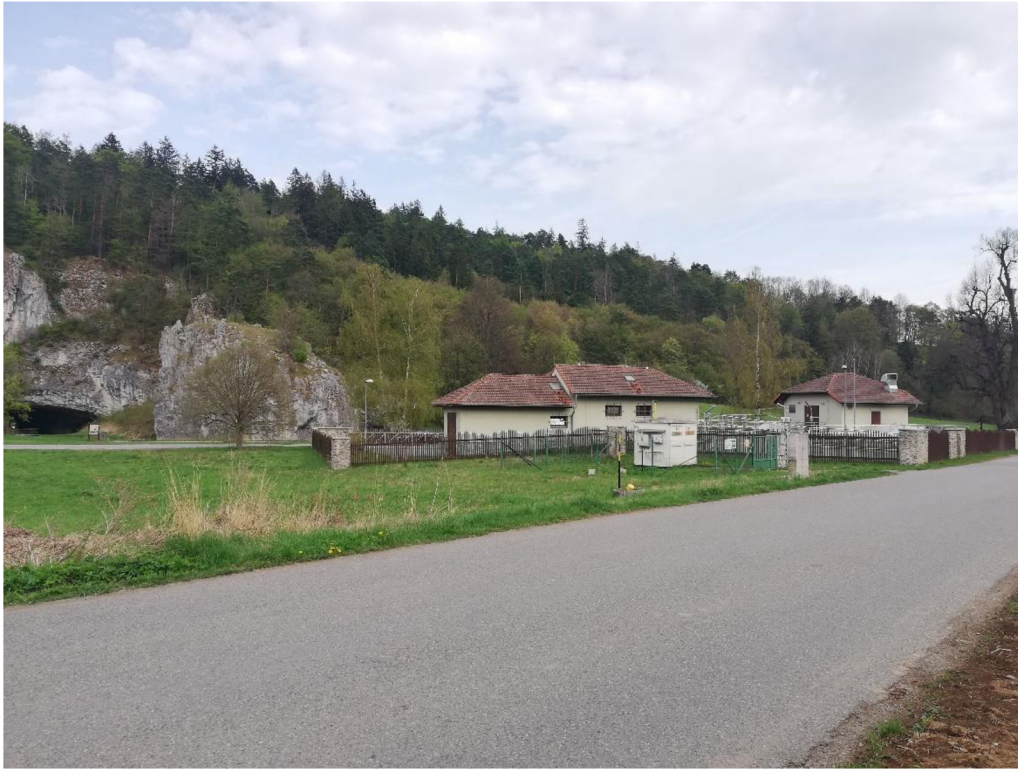
Příloha 5: Čistírna odpadních vod, v pozadí areál Sloupsko-šošůvských jeskyní, fotograf: Marcela Čachotská, jaro 2022
