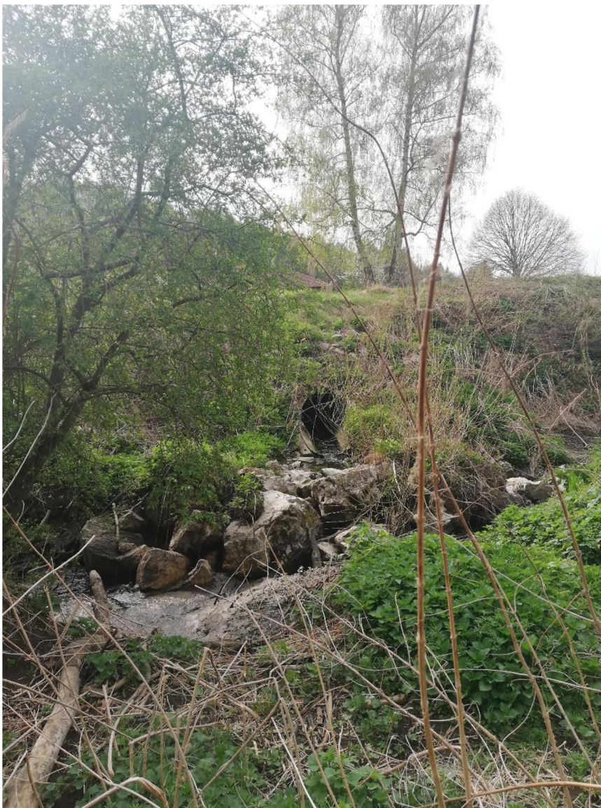
Příloha 11: Vypouštění vyčištěných vod z ČOV do závrtu PŽ/67 a Pon_Hřeb, fotograf: Marcela Čachotská, jaro 2022
