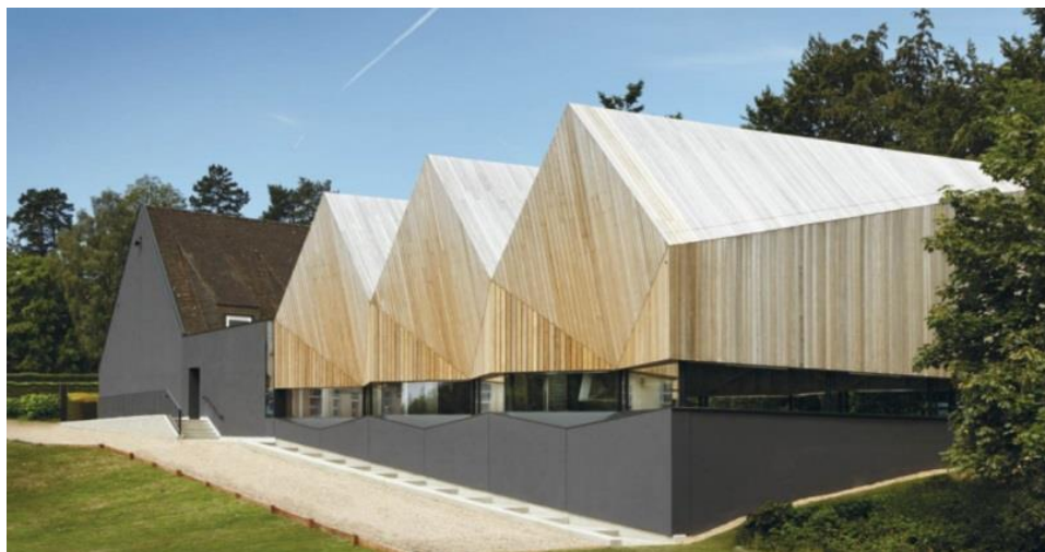
Obrázek 7: Zastřešení plaveckého bazénu, fraké, Buckinghamshire (Platowood B. V, 2020)
