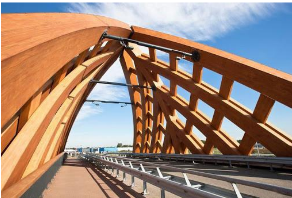
Obrázek 21: Mostová konstrukce, Sneek (Archdaily, 2020)
