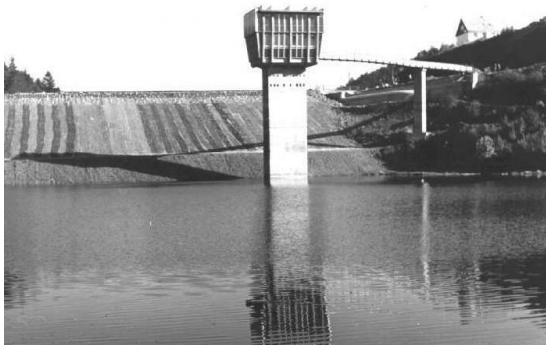
Obr 13: Hráz přehrady při výstavbě (lazinov.cz)
