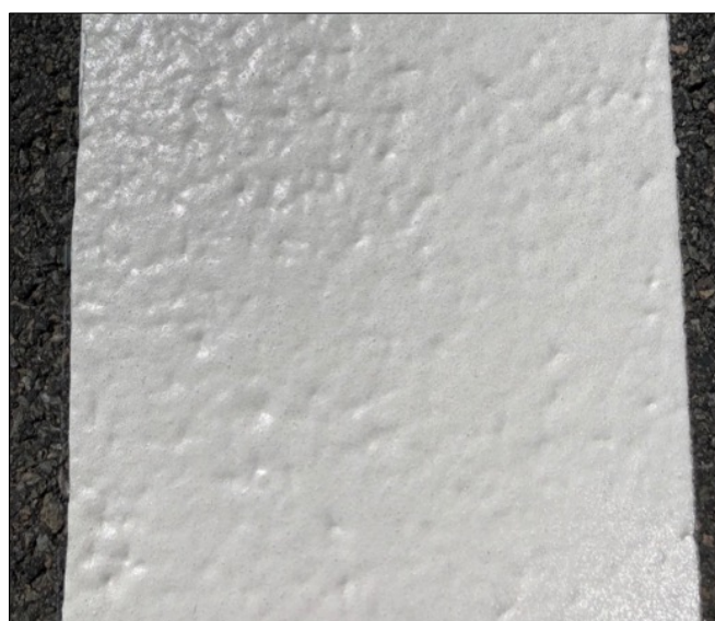
Obr. č. 51 Detail čerstvě zhotoveného vzorku TPP 2, vruby jsou uzavřené a nejsou již vidět [vlastní]
