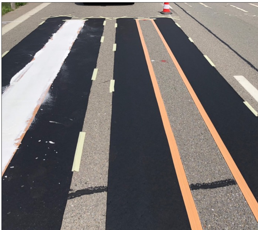
Obr. č. 61 Pravá čára vzorku KP 7 ve směru jízdy již zhotovená stěrkováním [vlastní]
