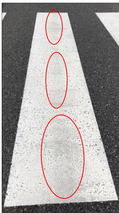
Obr. č. 86 Pohled na čáru po obnově, září 2018 [vlastní]
