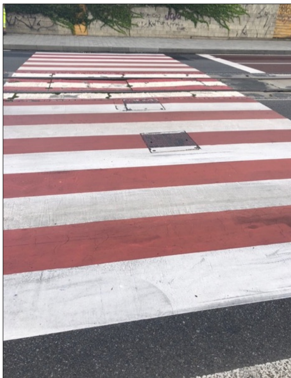
Obr. č. 76 Přechod pro chodce na ul. Poříčí [vlastní]
