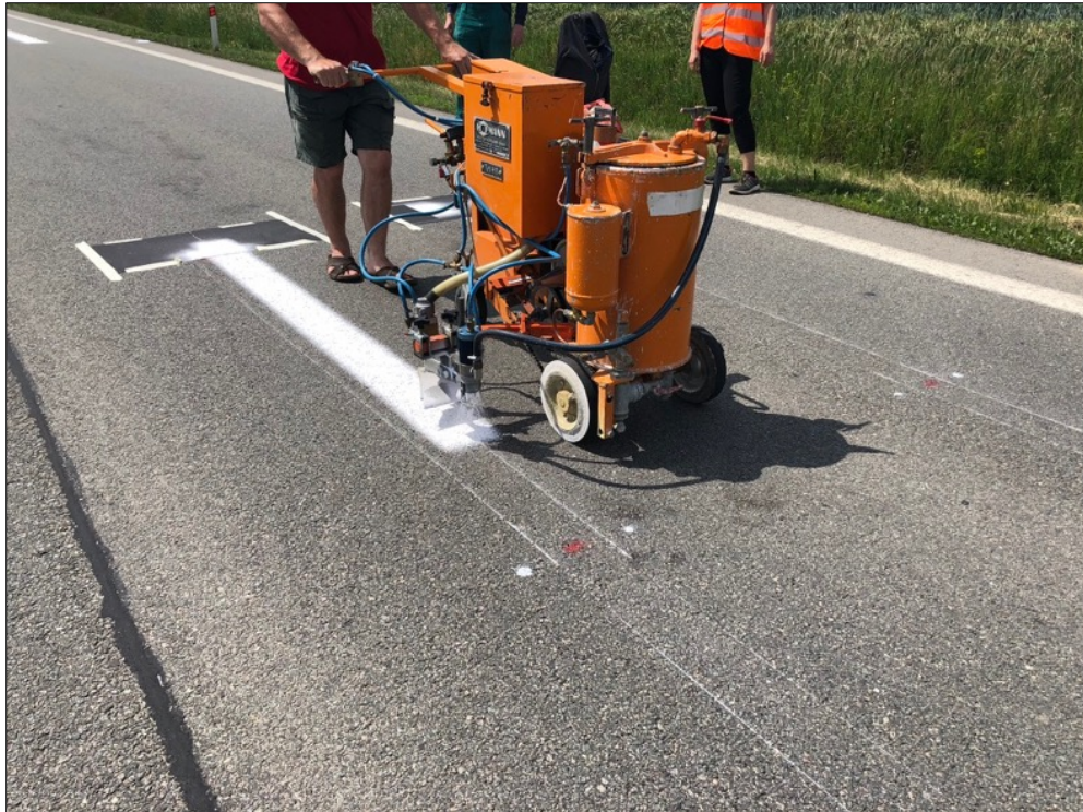
Obr. č. 57 Aplikace vzorku RBp 5 strojním zařízením Hofmann H 8 [vlastní]
