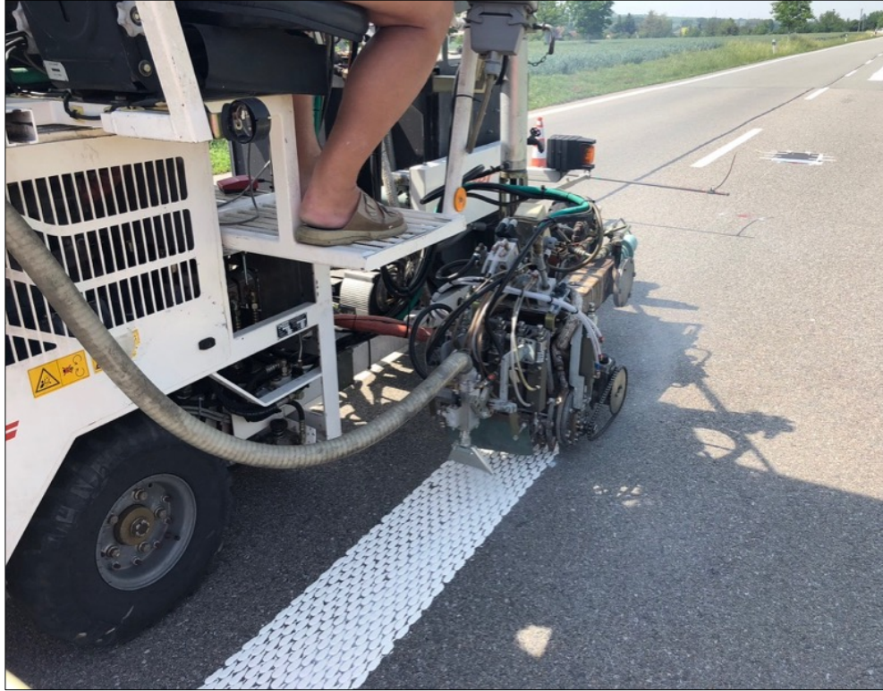
Obr. č. 59 Aplikace vzorku TP 6 strojním zařízením Hofmann H 18 [vlastní]
