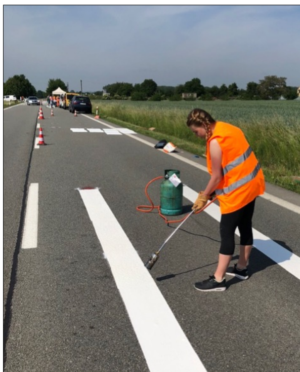
Obr. č. 49 Aplikace předem připraveného termoplastického materiálu pomocí plynového hořáku [vlastní]
