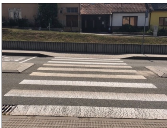
Obr. č. 79 Přechod před obnovou [vlastní]
