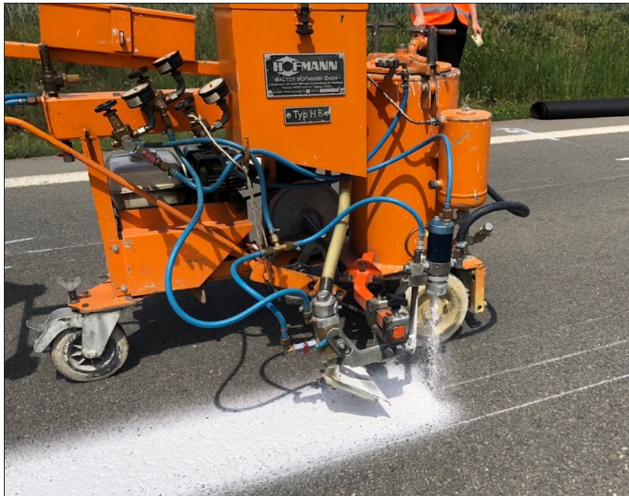
Obr. č. 55 Aplikace vzorku RB 4 strojním zařízením Hofmann H 8 [vlastní]
