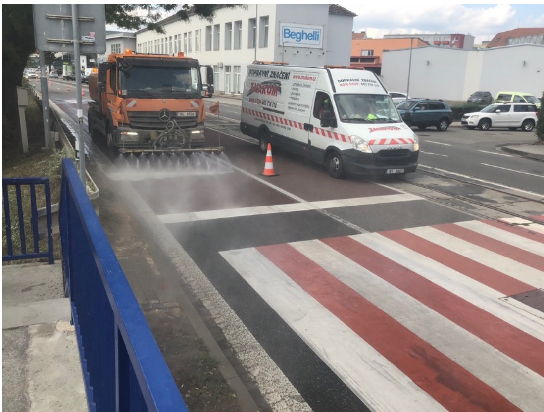
Obr. č. 11 Skrápění povrchu před zkouškami na mokřém povrchu, září 2018 [vlastní]
