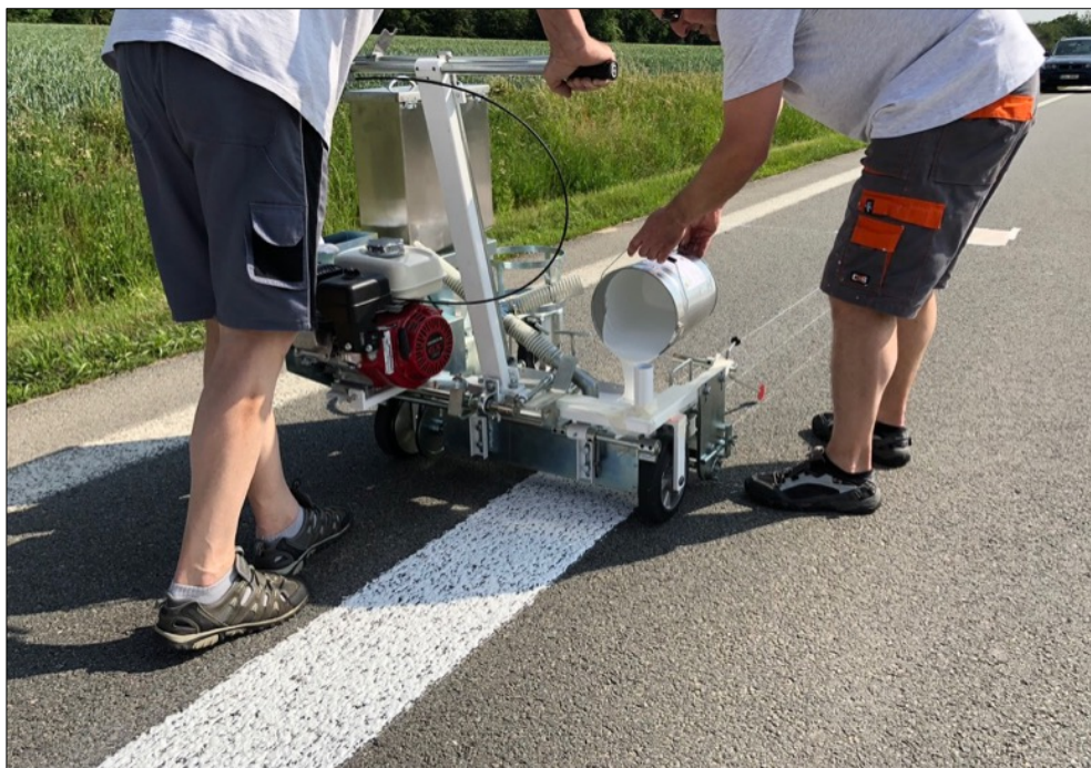
Obr. č. 52 Aplikace vzorku KPS 3 pomocí strojního zařízení Hofmann Junior [vlastní]
