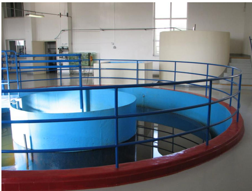
Obr. 14: Přítoková kašna (zcela vpravo) a čiči 1 typu „osvětlitel“ s kašnou
