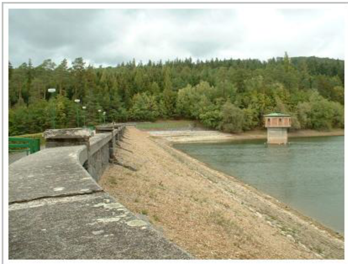
Obr. 4: Sypaná hráz a odběrná věž [1]
