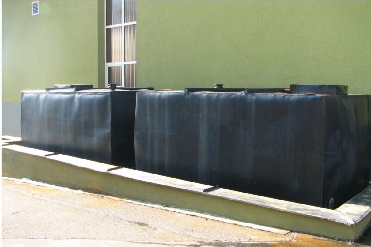
Obr. 12: Zásobní nádrže na PREFLOC
