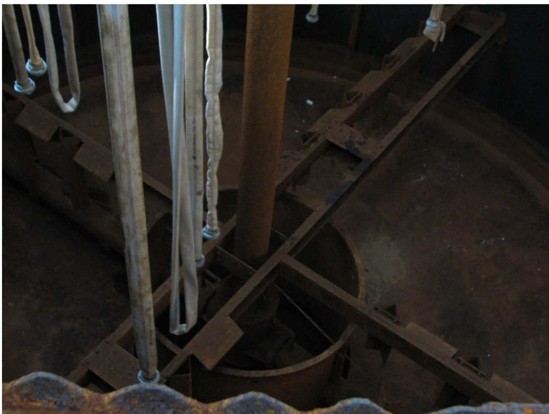
Obr. 15: Dno čičice Dorr-Oliver (dlouhodobě mimo provoz)
