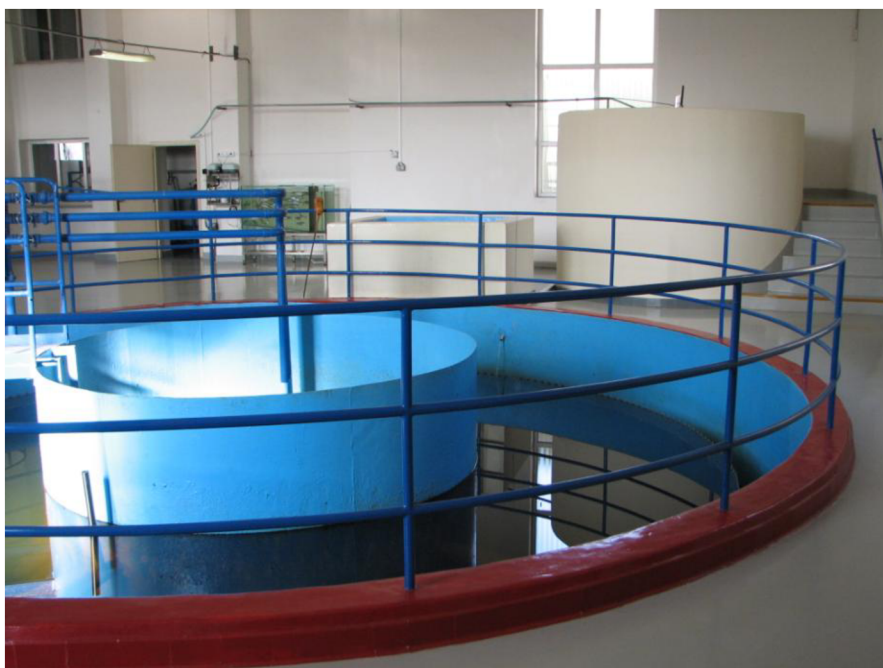
Obr. 14: Přítoková kašna (zcela vpravo) a čič 1 typu „osvětlitel“ s kašnou
