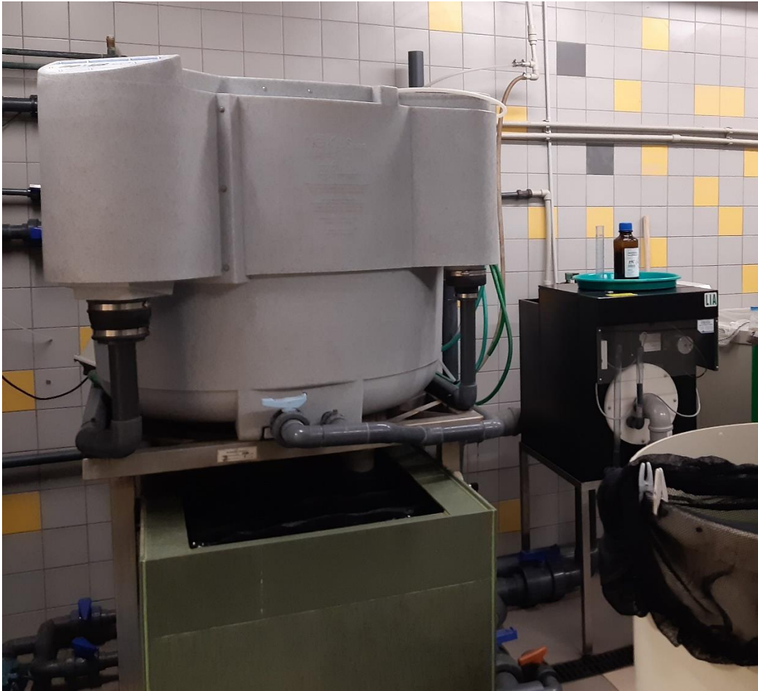
Obr. 6: Biologický filtr Nexus 310 (nahore), biologický filtr vlastní výroby (dole) a mechanický filtr od firmy Ratz Ltd. (vpravo; vlastní archiv autora)
