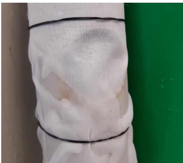
Obr. 9: Uzavření odtoku z nádrže pomocí uhelonové tkaniny (vlastní archiv autora)
