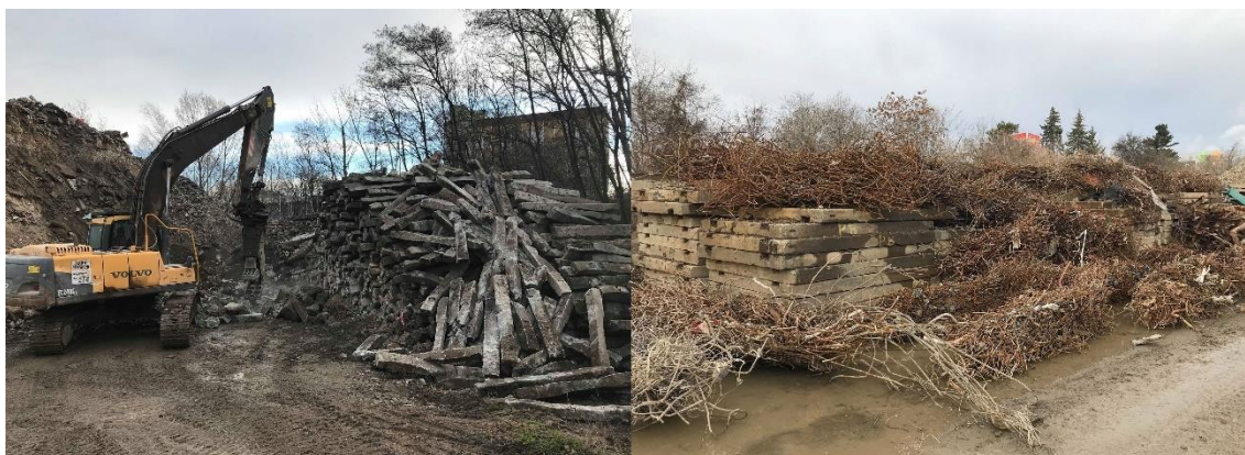
Obrázek 6: Vydrčování výztuže, KARE Praha s.r.o.
