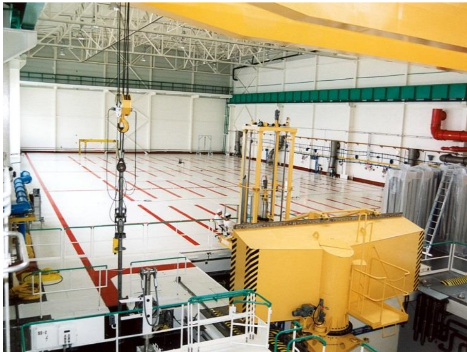
Obr. 2-4: Mokrý mezisklad vyhořelého paliva JE Jaslovské Bohunice, převzato z [6]
