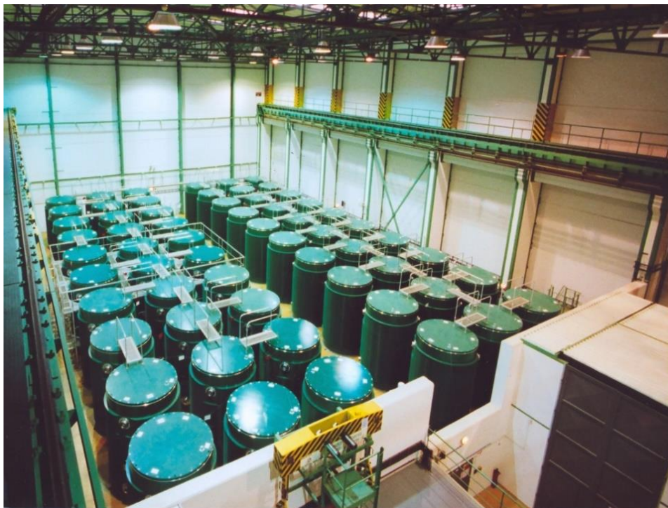
Obr. 3-3: Mezisklad vyhořelého jaderného paliva JE Dukovany, převzato z [9]
