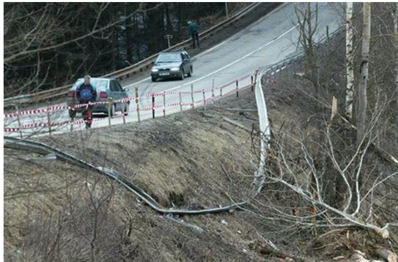
Obrázek č. 2 – Místo dopravní nehody - vozovka Děj dopravní nehody 1/2
