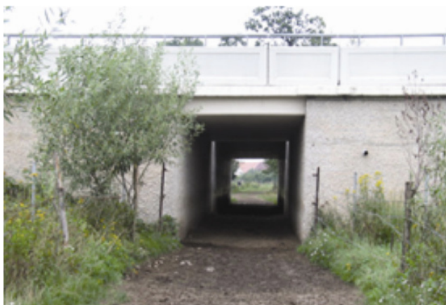
Obrázek 16: Ekodukt s tunelovou konstrukcí (Beben 2012)
