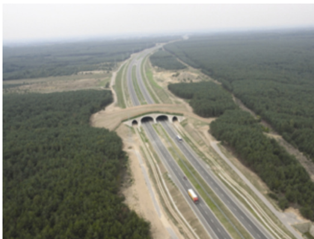
Obrázek 15: Ekodukt s mostní konstrukcí (Beben 2012)
