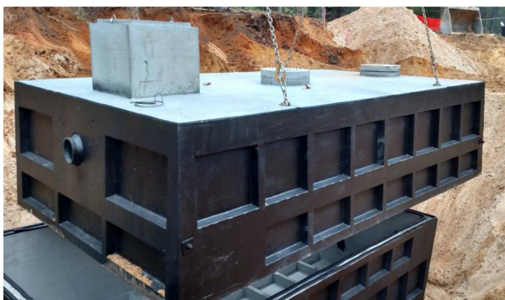
Obrázek 6: Betonová prefabrikovaná retenční nádrž (ZAKRA, 2022)
