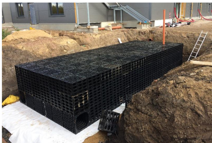
Obrázek 7: Objekt ze vsakovacích bloků (TZB-info, 2021)
