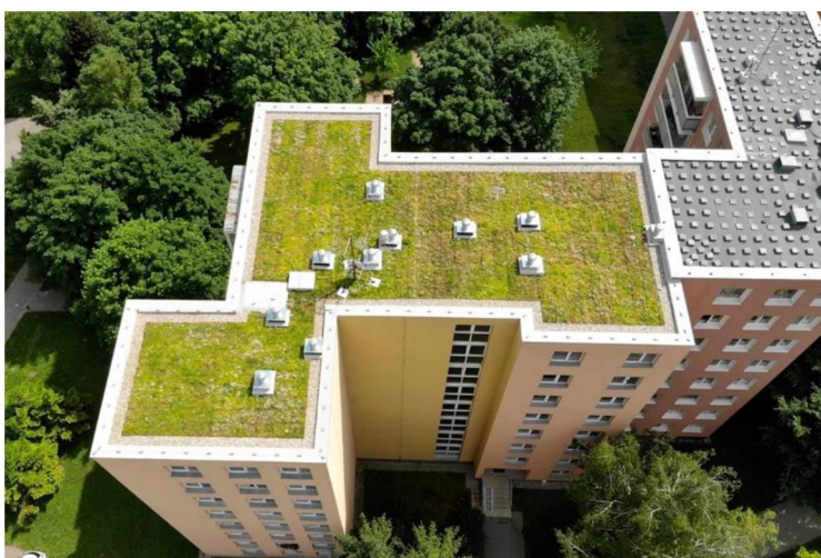
Obrázek 8: Zelená střecha na panelovém domě (Adaptterra Awards, 2023)
