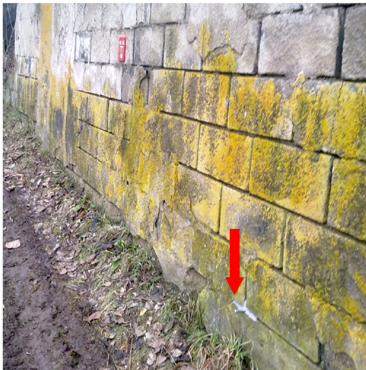
Obr. 5.3 Stabilizace nivelačního bodu N1
