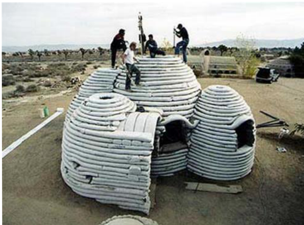
Obr. 6 Superadobe hlinená stavba
