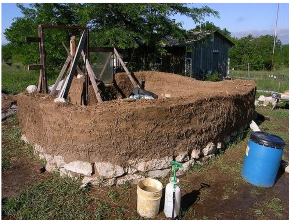
Obr. 2 Cob hlinená stavba
