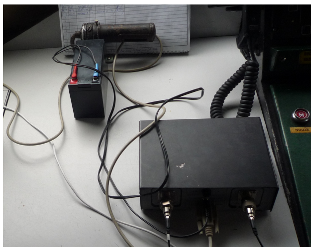
Obr. 4.4: Měřicí přístroj s baterií
