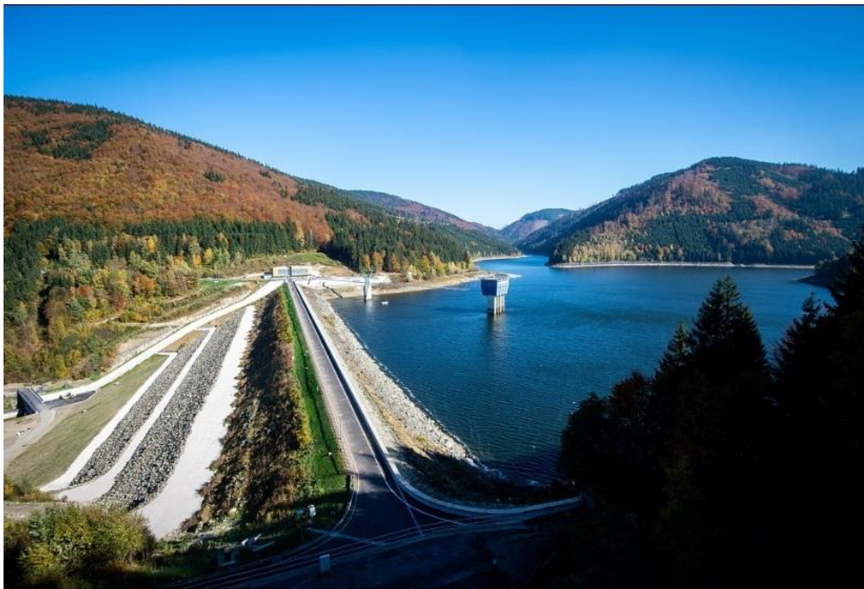
Obr. č. 3 Přehrada Šance [7]
