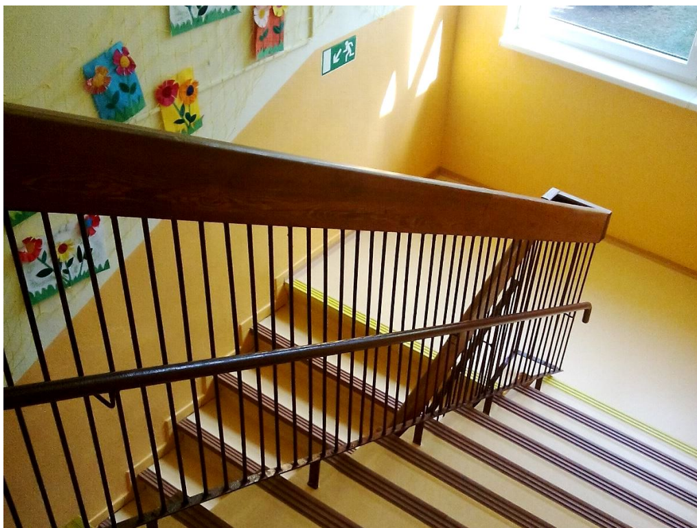
Schodiště z přízemí MŠ do prvního patra k třídě Medvědů.
