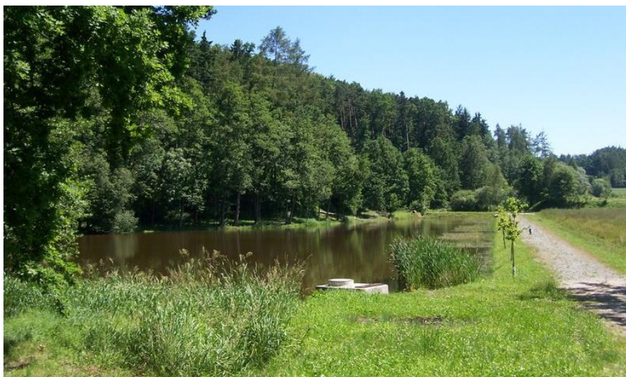
Obr. 13 Vodohospodářské opatření, k.ú. Vídov
