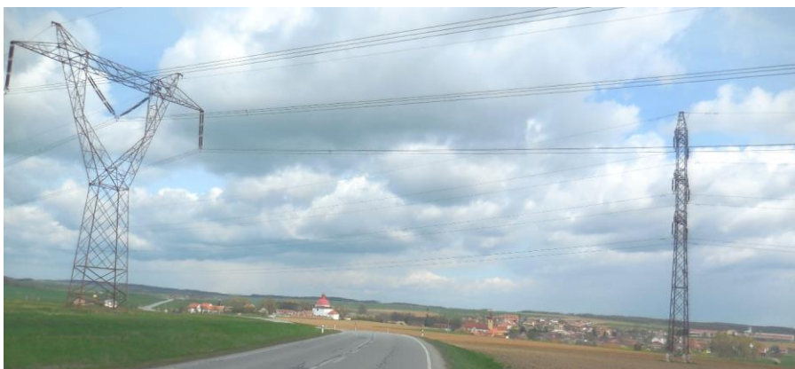
Obr. 45 Vedení vysokého napětí jako neestetický prvek v pohledovém horizontu
