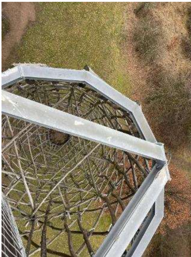
Rozhledna Doubravka – pohled na konstrukci
