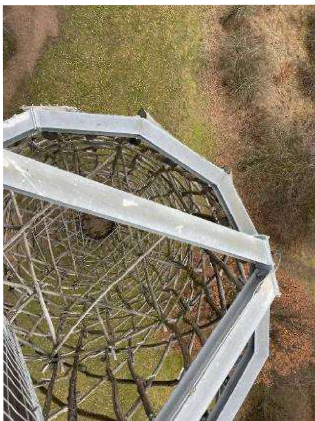
Rozhledna Doubravka – pohled na konstrukci
