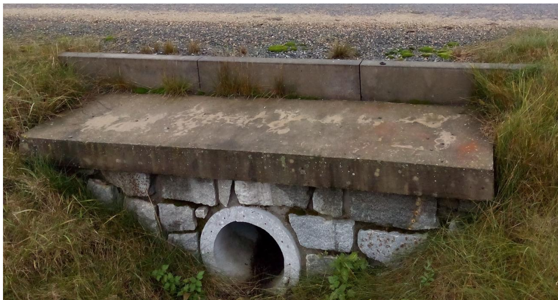
Obrázek č. 15: Skutečný stav propustku Pv 11/2
