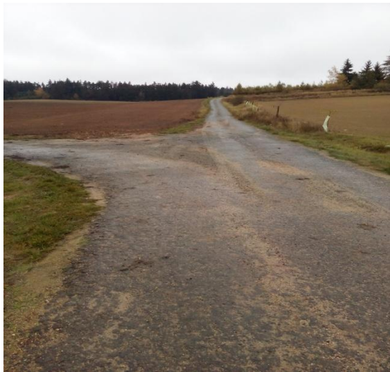
Obrázek č. 5: Křižovatka polních cest Pv 11 a Pv 12 - foto
