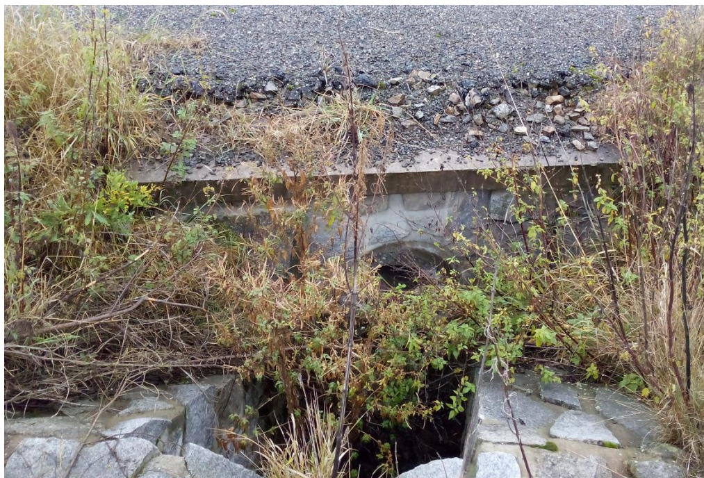
Obrázek č. 17: Šířka vtokové jímky Pv 12/1 - skutečný stav
