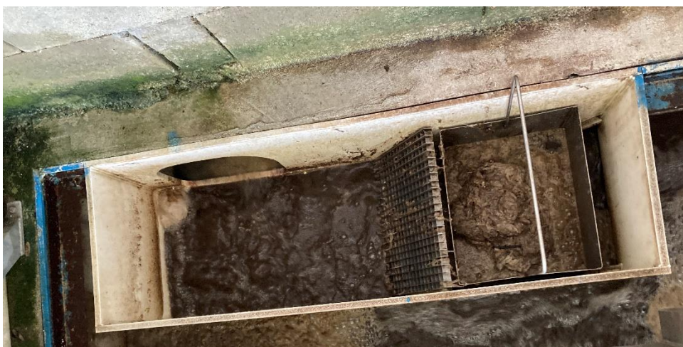
Obrázek 6.3: Ruční česle na ČOV Bošilec (vlastní zdroj, Jelínková J., 2023)
