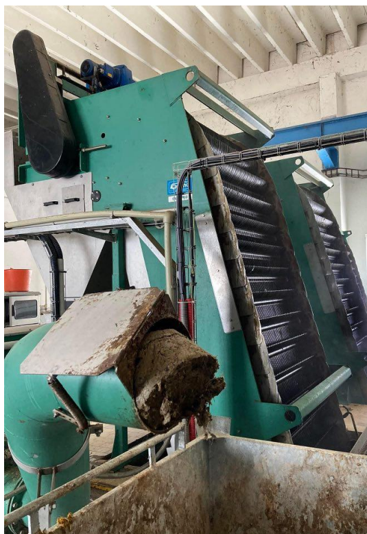
Obrázek 6.4: Strojní česle na ČOV Tábor (vlastní zdroj, Jelínková J., 2023)
