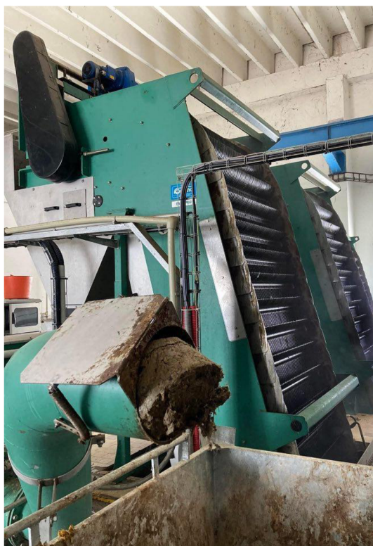
Obrázek 6.4: Strojní česle na ČOV Tábor (vlastní zdroj, Jelínková J., 2023)
