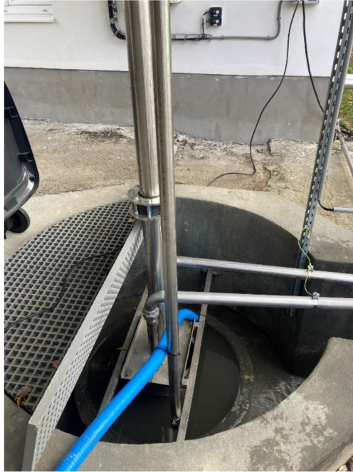
Obrázek 6.5: Vertikální lapák písku na ČOV Malšice (vlastní zdroj, Jelínková, 2023)
