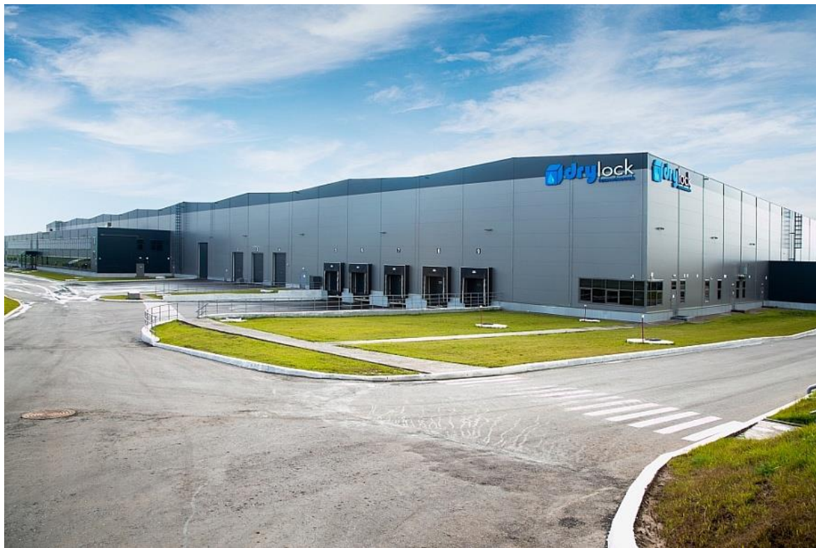
Obr. 3.1 Výrobní komplex společnosti Drylock Technologies.
