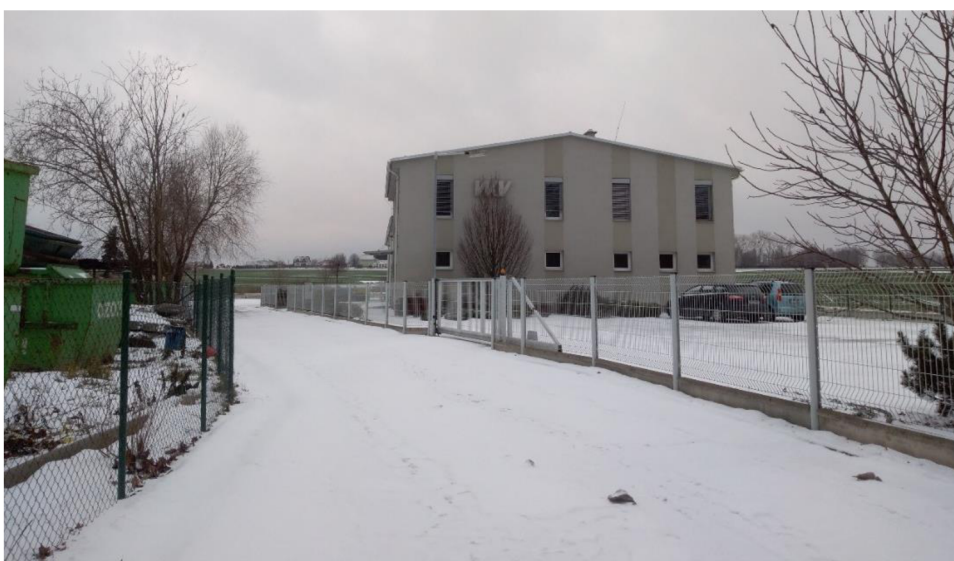
Obrázek 5.16 - Povodí č. 7 - Zastavěný pozemek
