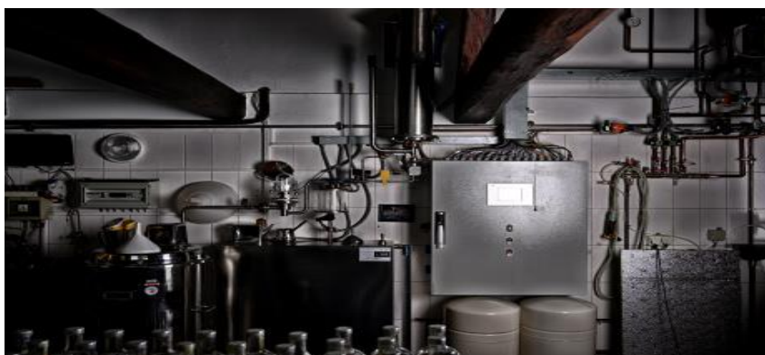
Obrázek 3 Celoměděná kolona na destilaci
