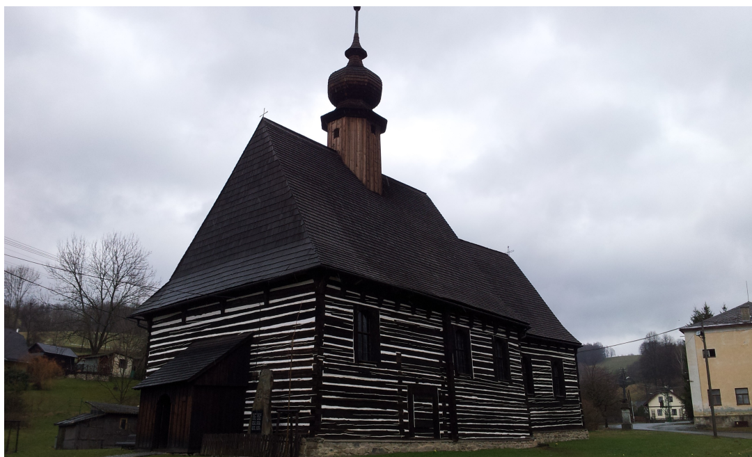
Obr.7 Dřevěný kostel v Maršikově
