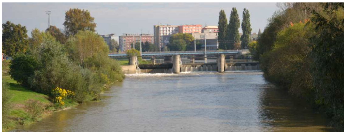
Obr. 3 Rozšířené koryto pod zrekonstruovaným jezem na řece Bečvě v Přerově (foto: Lampartová).
