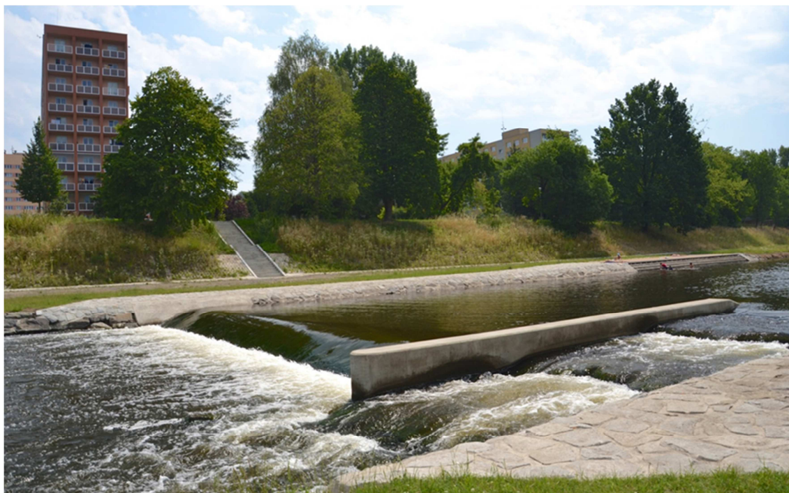
Obr. 28 Nově vybudovaný spodní jez s rybím přechodem (foto: Lampartová).
