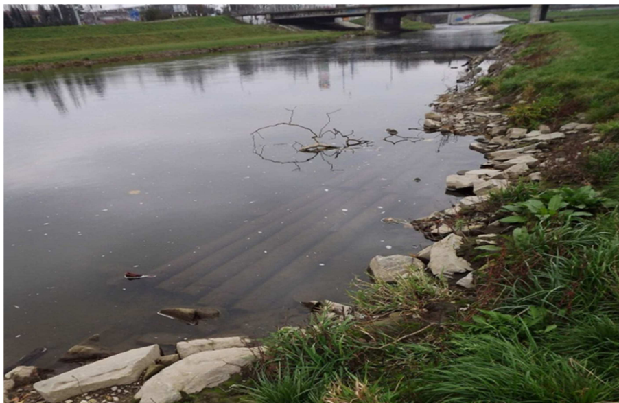
Obr. 37 Rybí srub vybudovaný na řece Moravě v Olomouci (foto: Lampartová).
