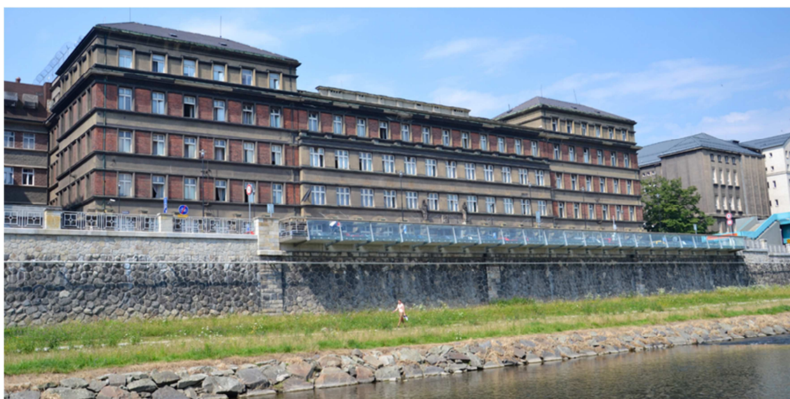
Obr. 31 Nově vybudovaná vyhlídková galerie na navýšené nábřežní zdi (foto: Lampartová).
