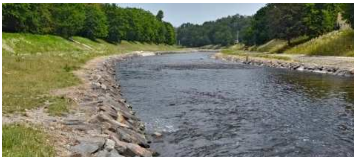
Obr. 30 Nově vybudované opevnění břehů řeky (foto: Lampartová).
